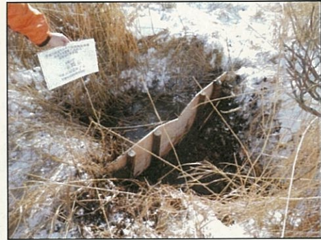
2011年12月1日 (仮堰設置)
